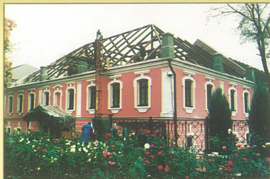
Реставрация крыши на монастырских келлиях
