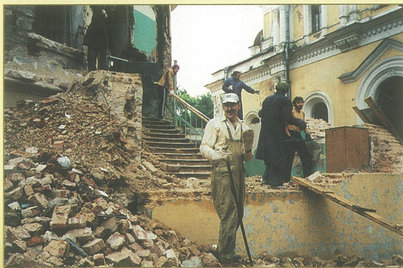
Начало реставрационных работ
