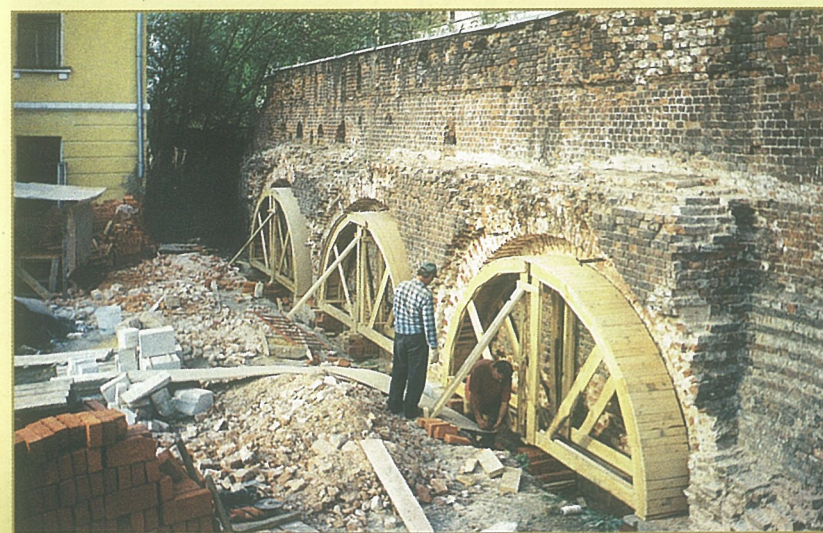
Начало реставрационных работ.
