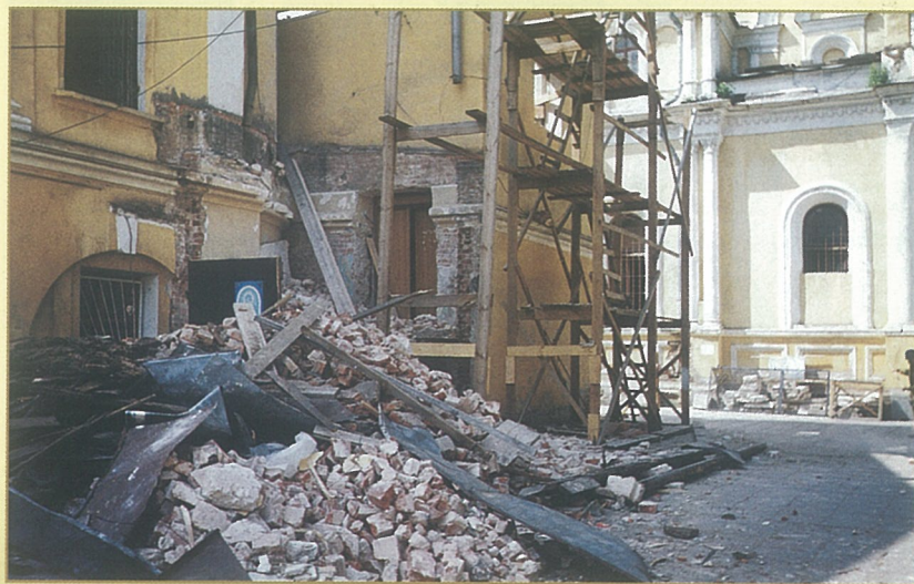
Начало реставрационных работ
